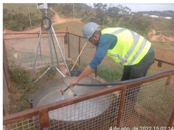
Foto 6 – Tanque do reservatório preenchido com água limpa. (Data: 04/08/2022).
