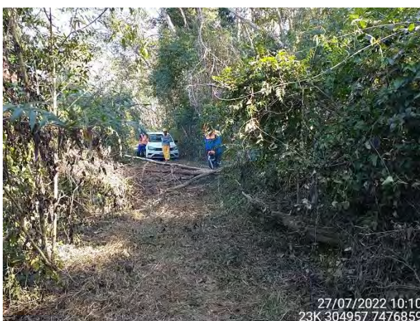
Foto 11 – Corte e remoção das árvores caídas no acesso. (Data: 27/07/2022).
