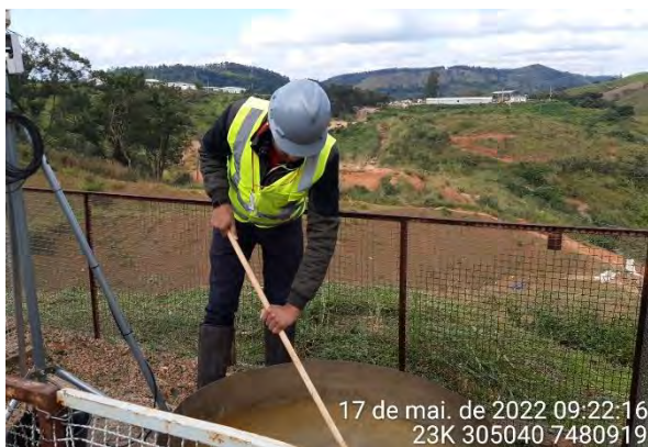
Foto 1 – Realização da atividade de limpeza da EMA. (Data: 17/05/2022).
