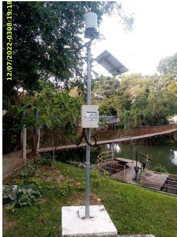
Estação Telemétrica Limpa (perto)
